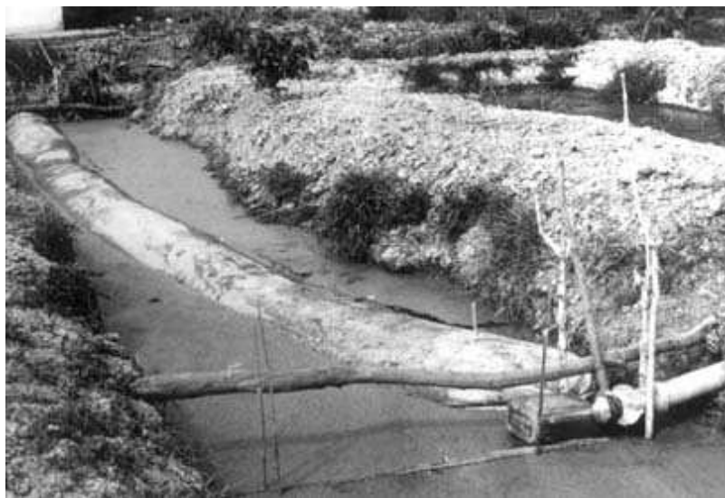
PHOTO/FOTO 8 A floating polyethylene biodigester Biodigester flottant en polyéthylène Biodigestor flotante de polietileno
