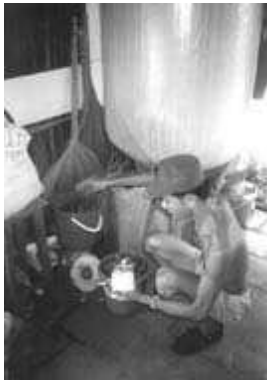
PHOTO/FOTO 6 A vertical biogas storage bag Sac vertical de stockage du biogaz Bolsa vertical para almacenar el biogás Photo/Foto: Lylian Rodríguez
